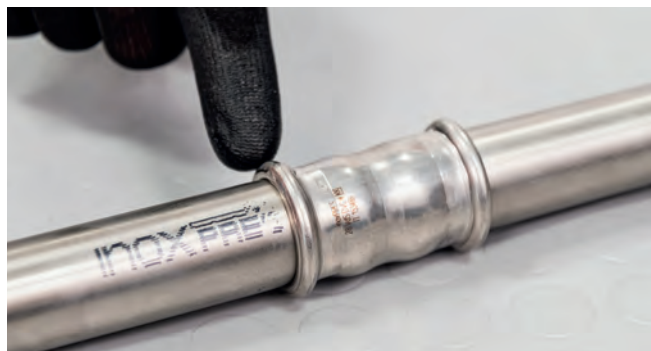
Ilustracja 38 – Kontrola połączenia prasowanego
