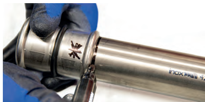
Ilustracja 32 – Oznaczanie głębokości włożenia za pomocą złączki
