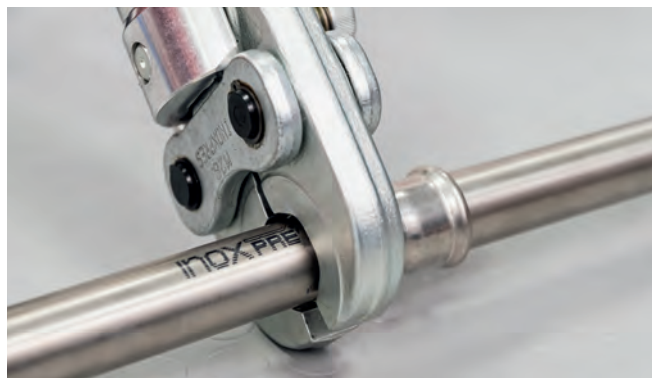
Ilustracja 37 – Wykonywanie połączenia zaprasowanego
