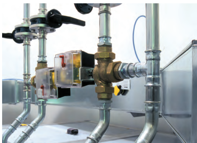
Ilustracja 23 - steelPRES – chłodnictwo (obieg zamknięty)
